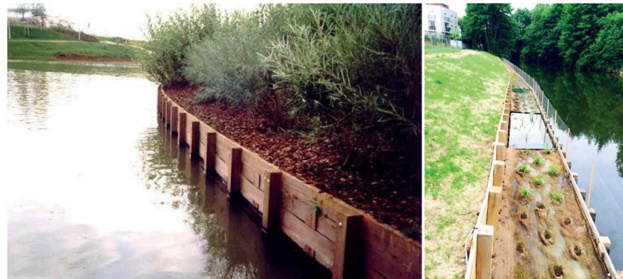
Figure 12 : Exemples de confortement de berges en tunage bois planté (Source : RWE)
